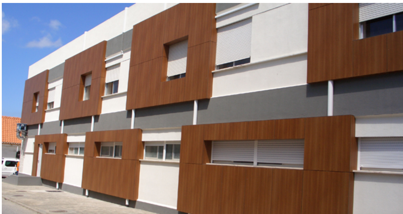
Instalações da UCA do Hospital do Montijo
