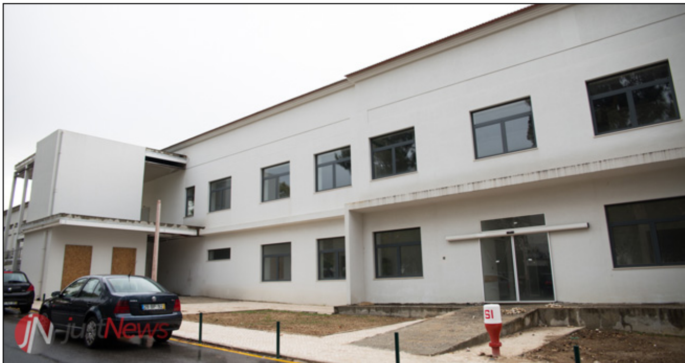
Futuras instalações da USF das Conchas.
